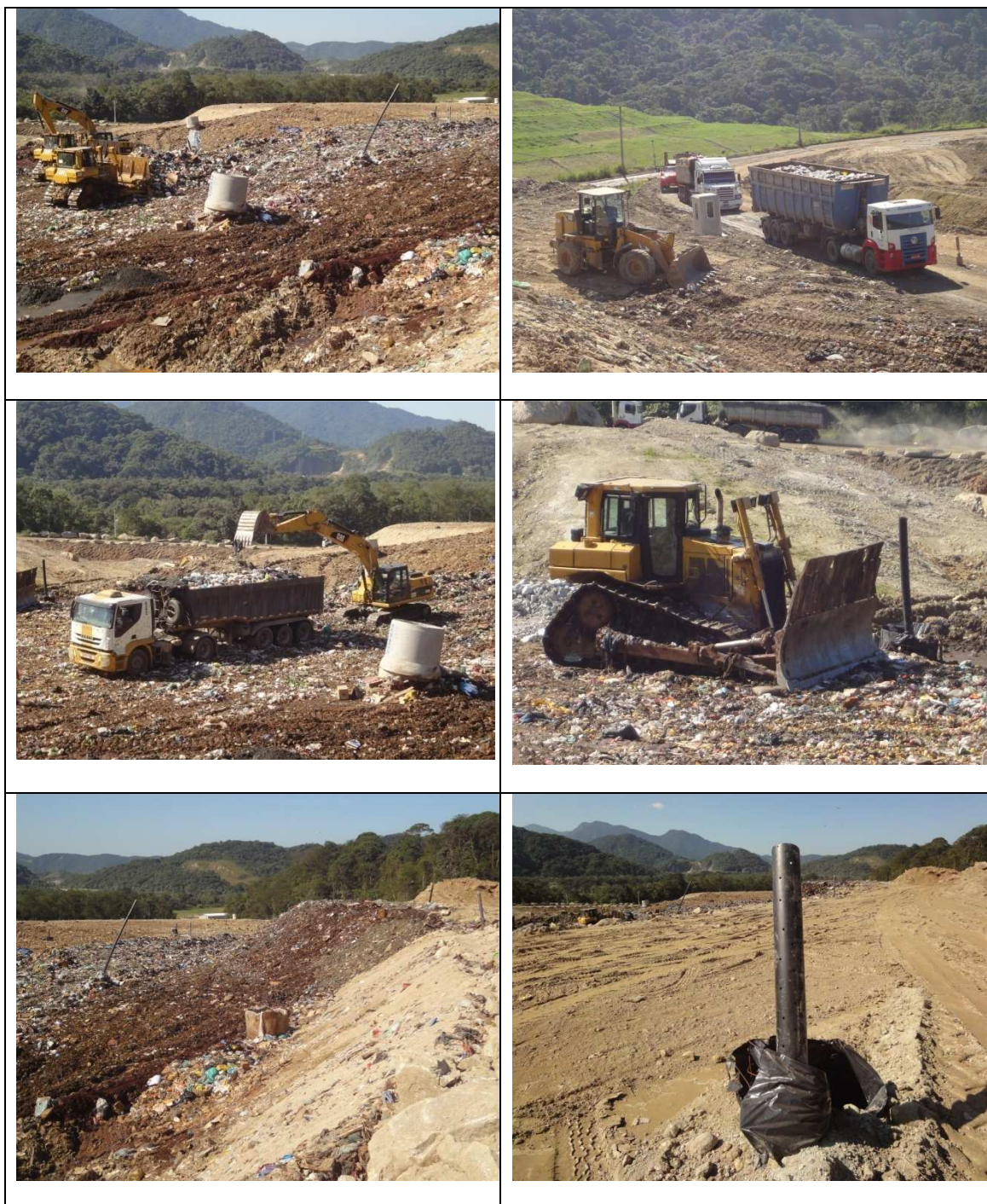
Figura 19 Operação do Sub-Aterro 2
