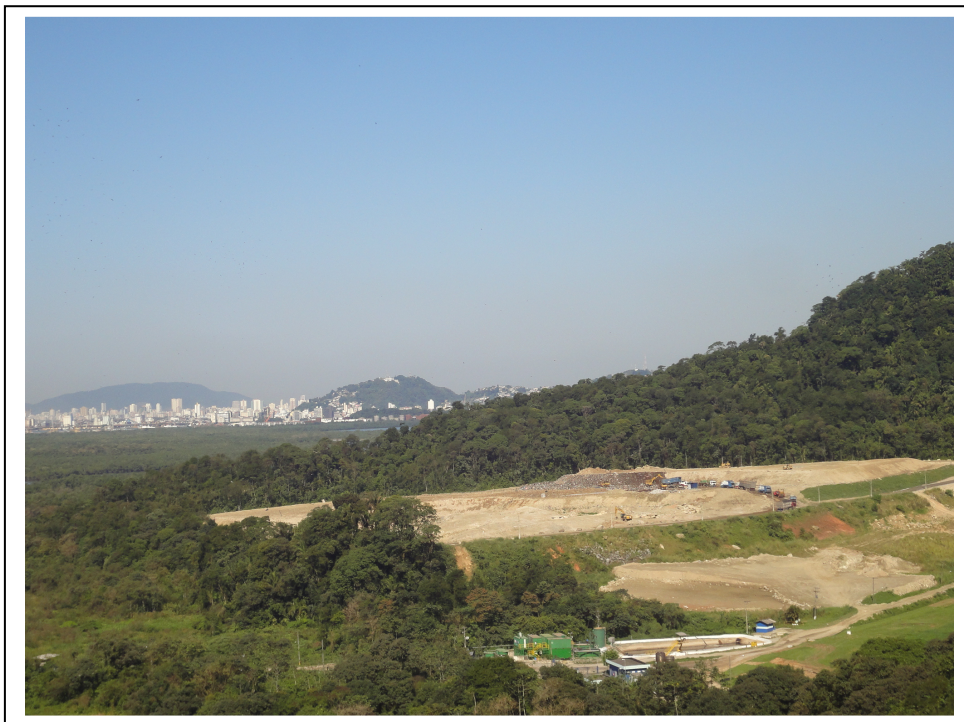
Figura 16 Vista geral do aterro sanitário da Terrestre Ambiental
