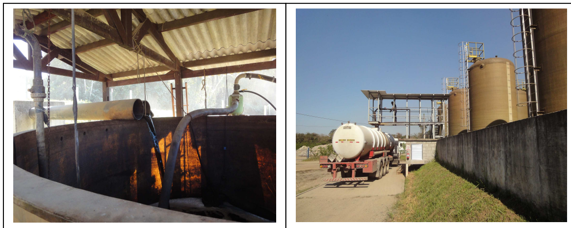
Figura 20 Armazenamento e carregamento de chorume nos caminhões tanque
