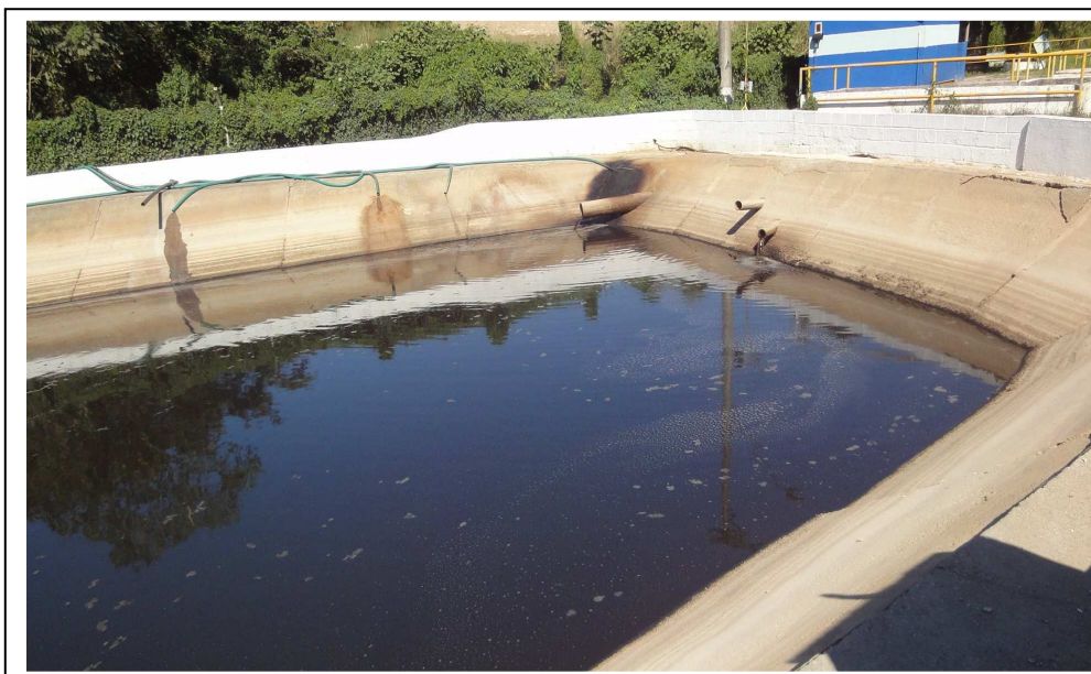
Figura 18 Tanques de armazenamento de chorume
