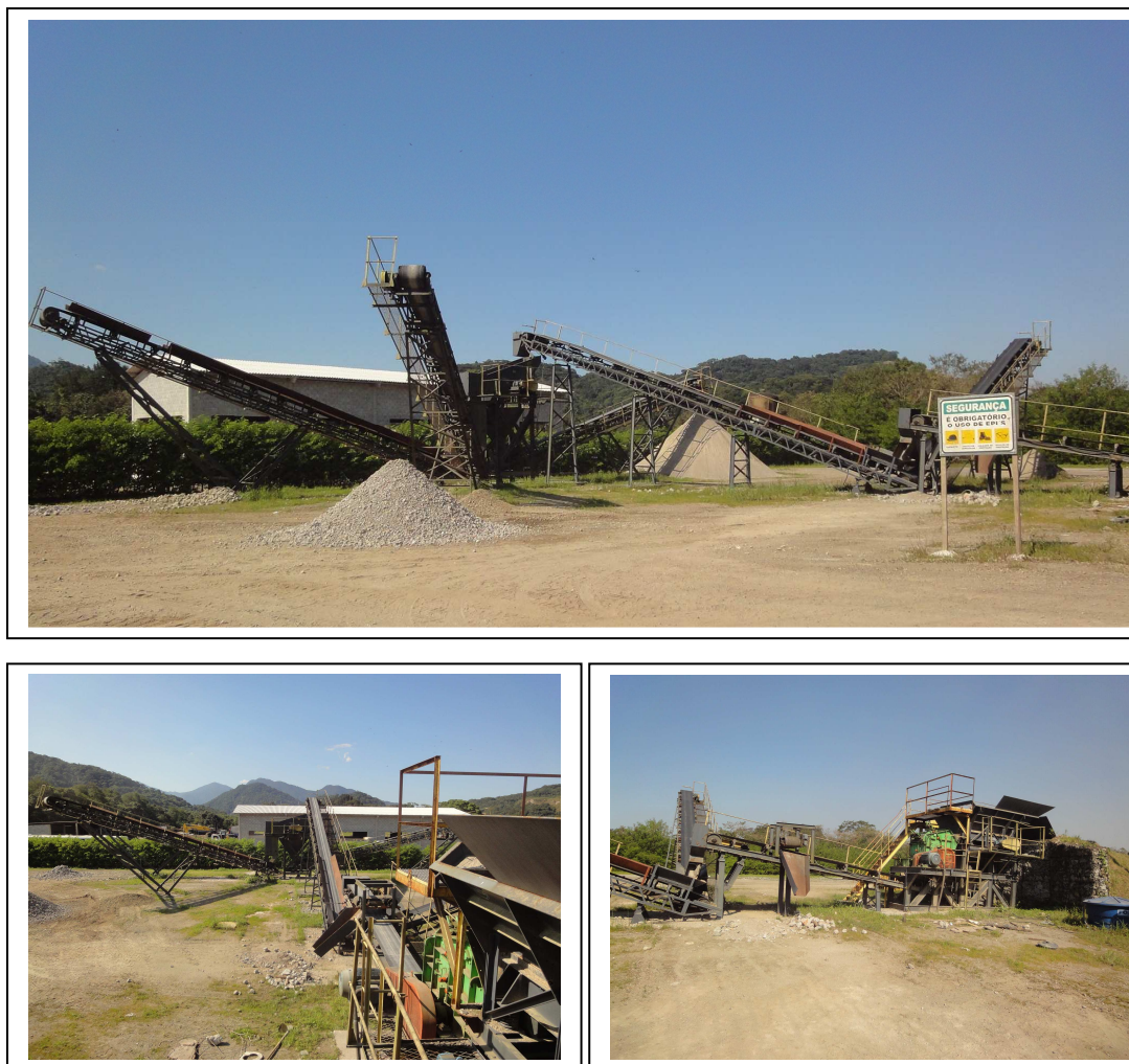
Figura 23 Usina de triagem e beneficiamento de Resíduos de Construção Civil
