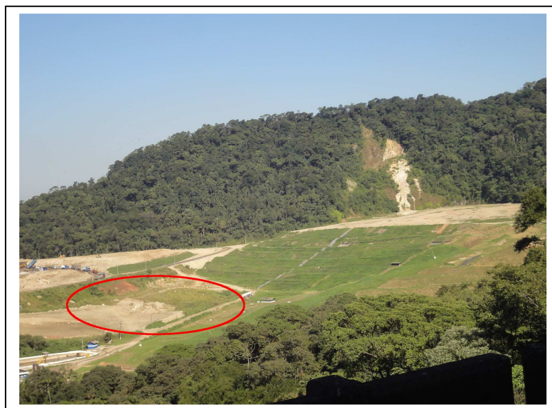
Figura 21 Destaque da localização da futura área do Sub-Aterro 3 (em fase de licenciamento)
