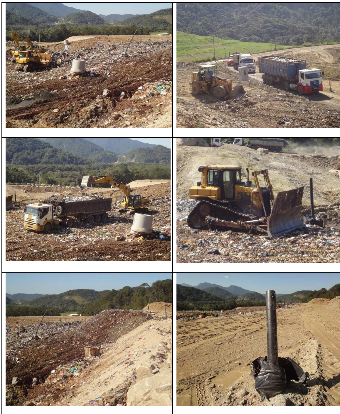
Figura 19 Operação do Sub-Aterro 2
