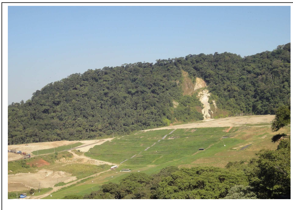
Figura 17 Vista do Sub-Aterro 1 – área encerrada
